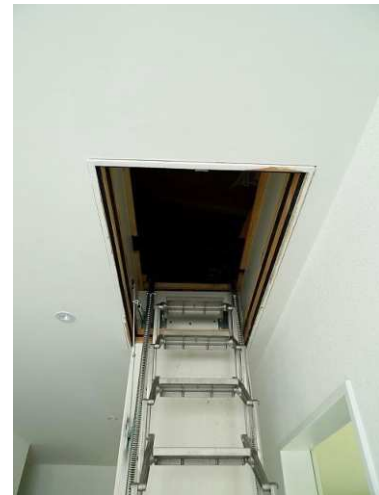
58 Zugang zu Dachestrichboden
