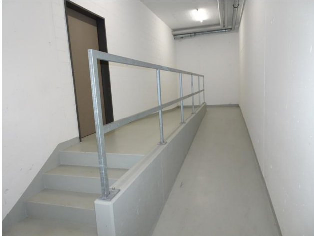
UG Rampe zur Tiefgarage
