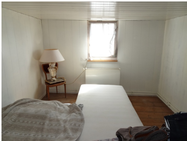
OG ex 27 Zimmer südwest
