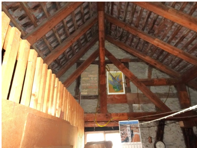
DG Estrich Dach Südseite
