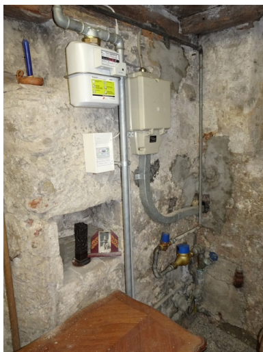
UG ex Nr. 27 Keller südost Leitungen
