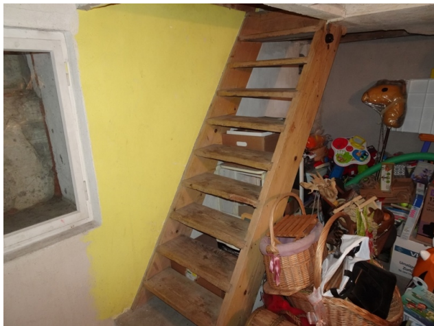
UG ex Nr. 29 Keller nordwest Treppe
