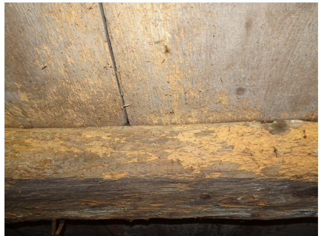
UG ex Nr. 27 Keller südost Deckendetail
