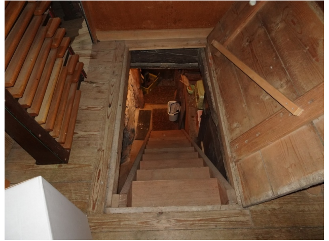
EG ex Nr. 27 Kellerzugang ost
