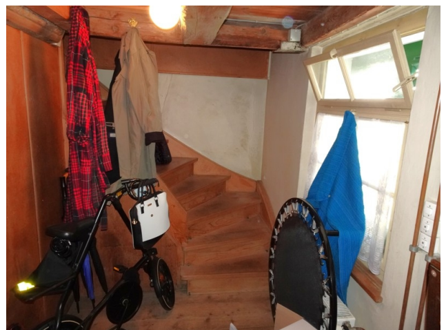
EG ex Nr. 27 Entrée Treppe zu OG ost
