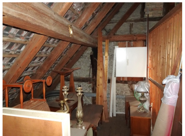
DG Estrich Südostecke
