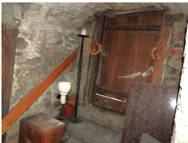
UG ex Nr. 27 Kelleraussenzugang ost
