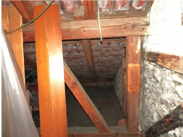
DG Estrich Nordwestecke
