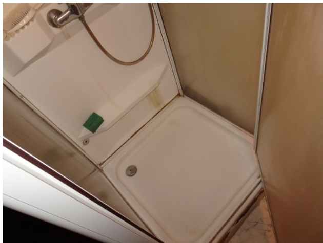
DG Bad nordost
