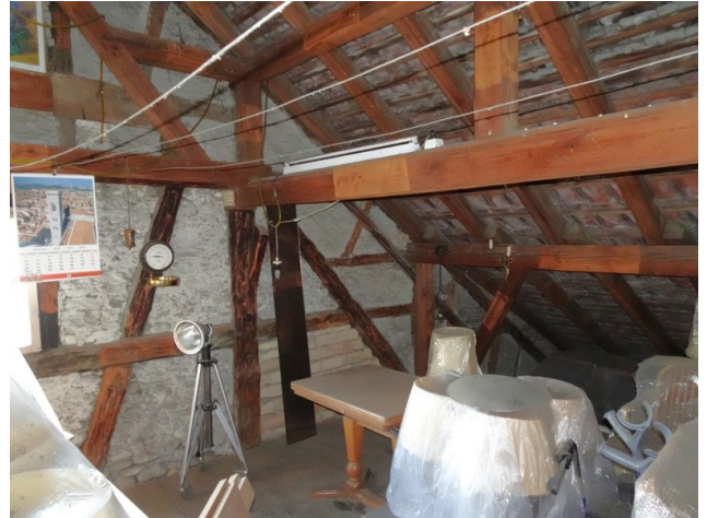
DG Estrich Südwestecke
