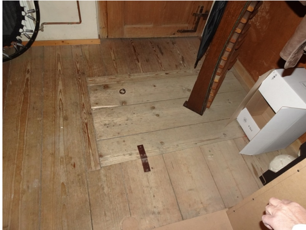
EG ex Nr. 27 Entrée Treppenklappe zu UG ost
