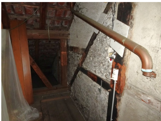
DG Estrich nordwest
