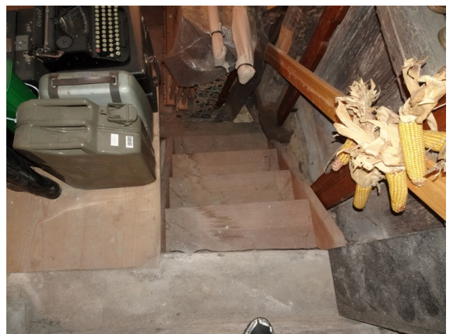
UG ex Nr. 27 Kellertreppe ost
