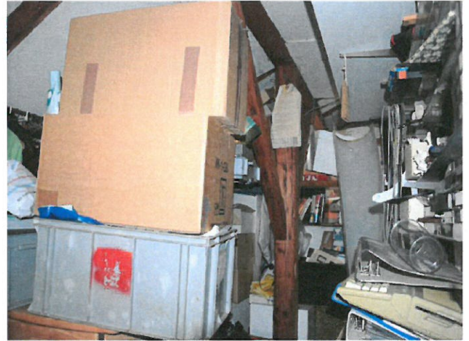
Raum hinter Waschraum
