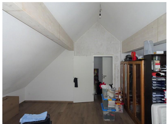
Estrich (Zimmer) südseitig
