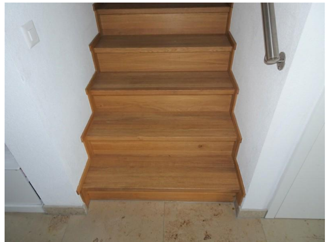
EG Treppe zu OG
