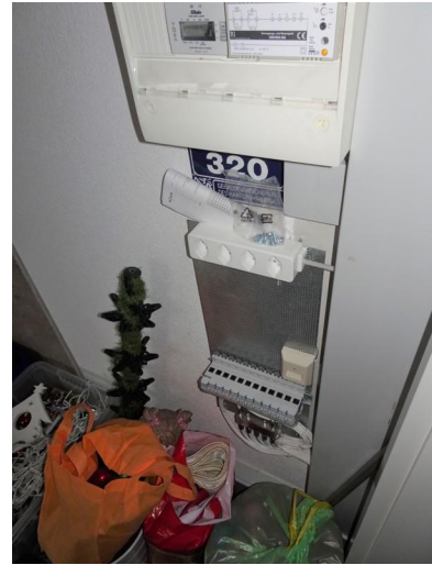
Technik südwest Mediaverteilung
