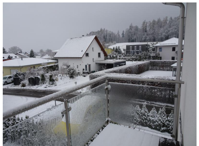
OG Westbalkon Nordseite
